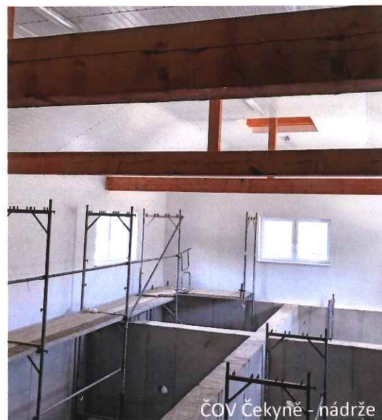
Stavba ČOV Čekyně
