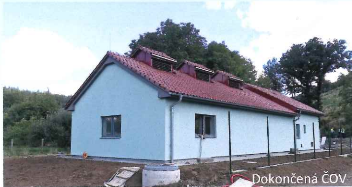
Stavba ČOV Čekyně
