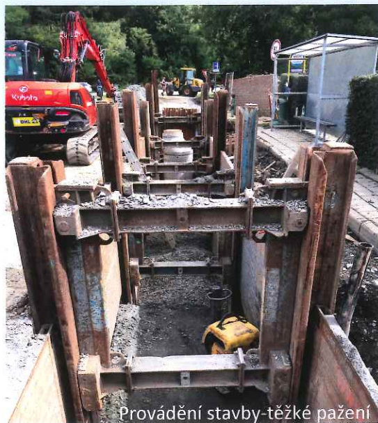
Stavba kanalizace na návsi v Čekyni
