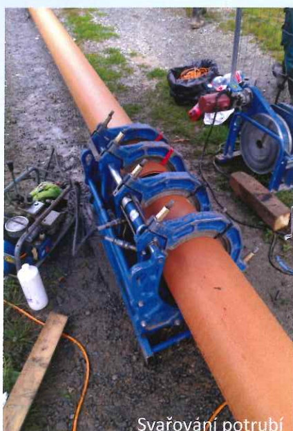
Oprava zatrubněného potoka
